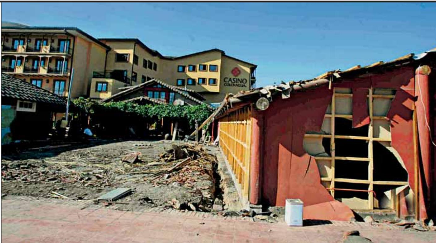
El pabellón que quedó con graves fisuras tras el terremoto debió ser demolido completamente.
